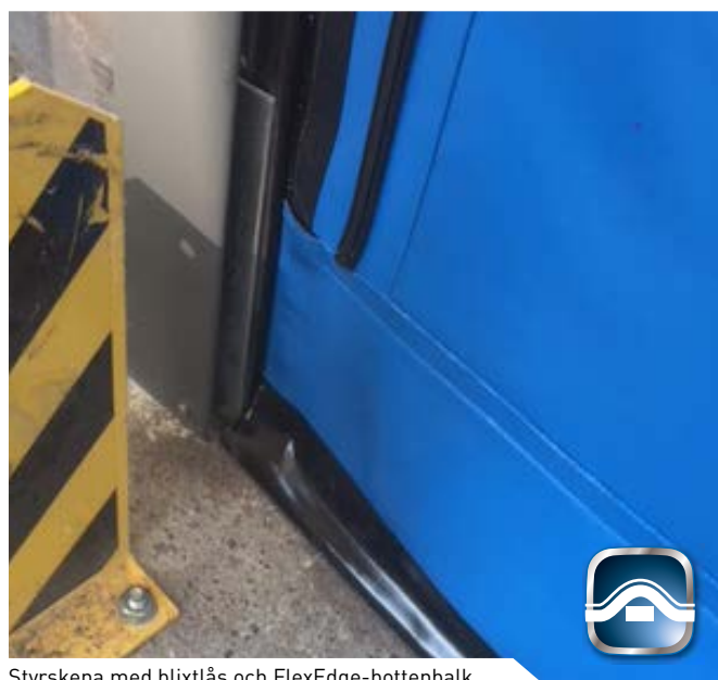
Styrskena med blixtlås och FlexEdge-bottenbalk
